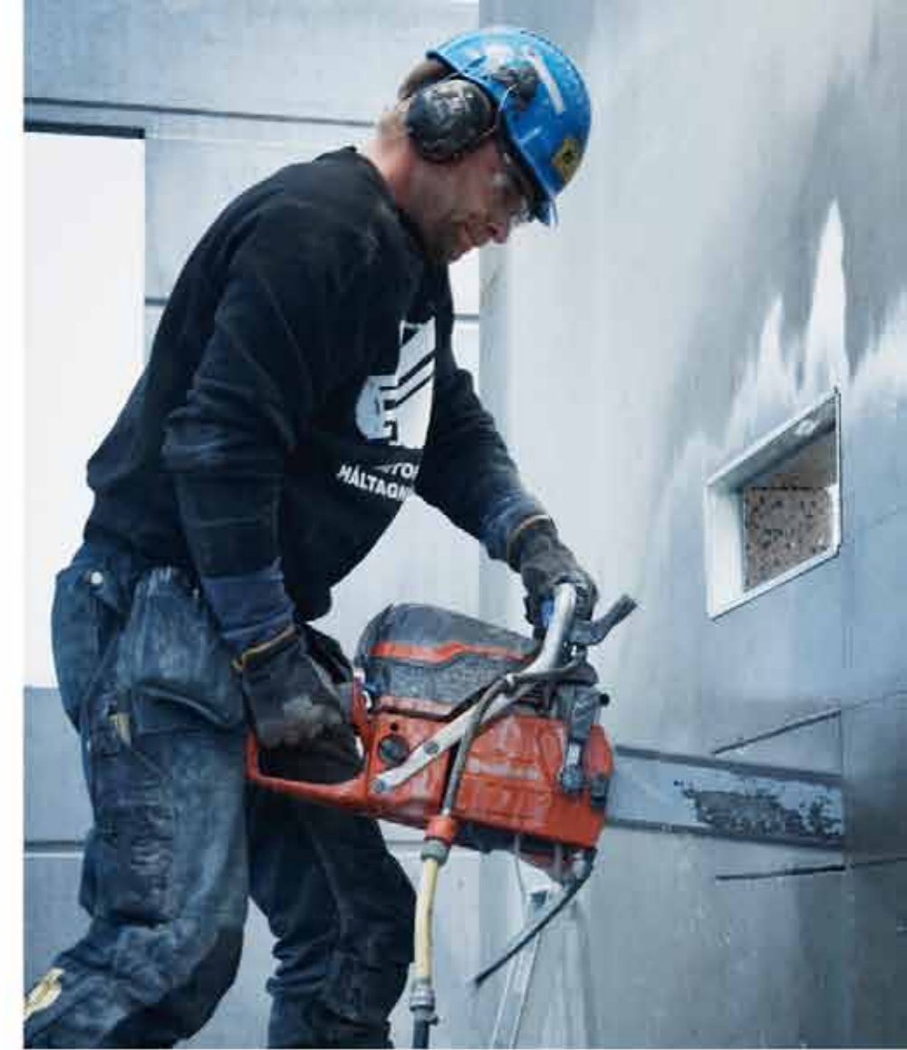
Hloubka řezu z jedné strany dosahuje až 390 mm.
