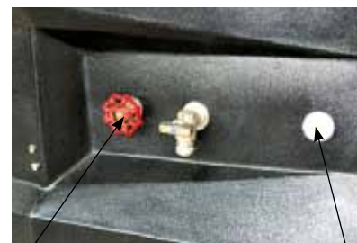
REGULACE PRŮTOKU VODY
