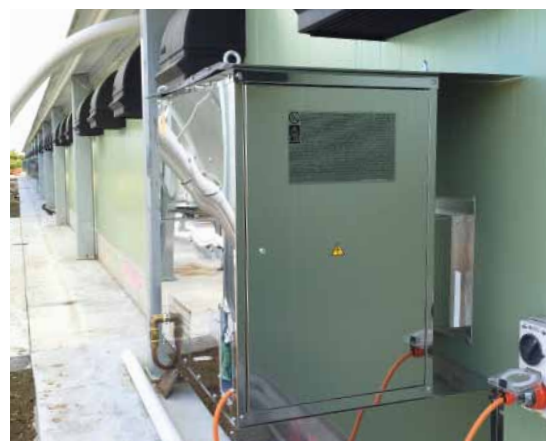
Montáž vně budovy
